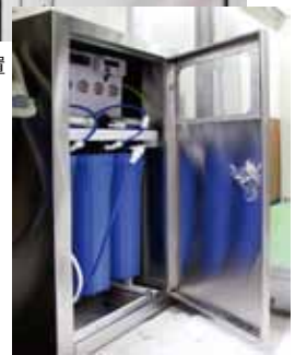
純水集中タンク・制御盤と純水製造装置 (この工場では設置スペースの関係で 機器を分散配置しています。)
