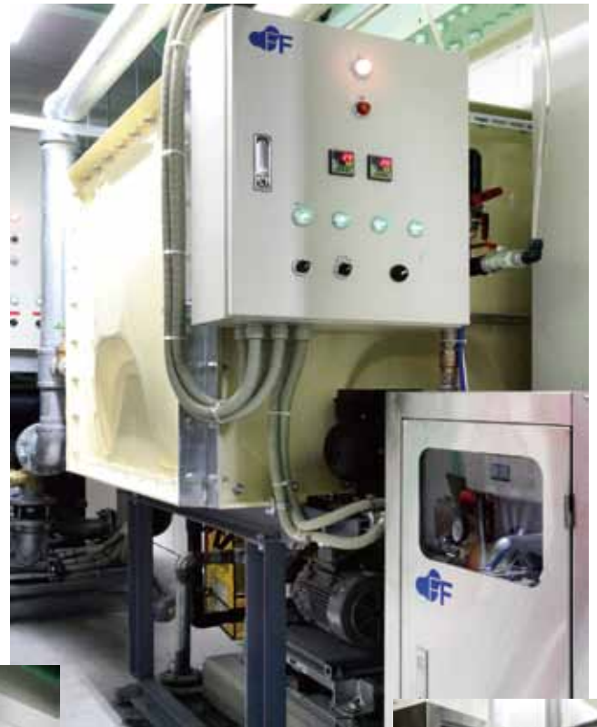
純水集中タンク・制御盤と純水製造装置 (この工場では設置スペースの関係で 機器を分散配置しています。)
