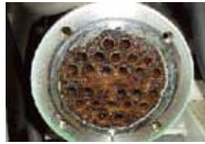
錆の発生したオイルクーラー
