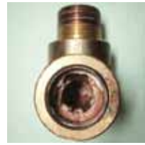
スケールの堆積した温調機配管
