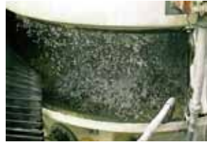
藻や微生物の大量に発生した クーリングタワー
